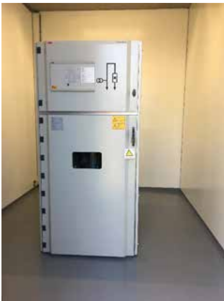
Is-limiter en eigen-bedrijf trafo
