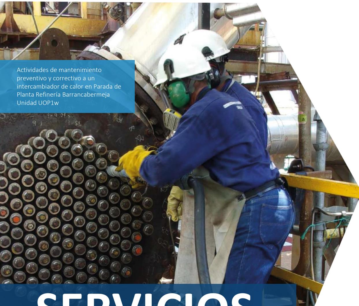
Actividades de mantenimiento preventivo y correctivo a un intercambiador de calor en Parada de Planta Refinería Barrancabermeja Unidad UOP1w
